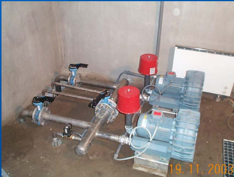
Blowers met luchtdistributiesysteem
